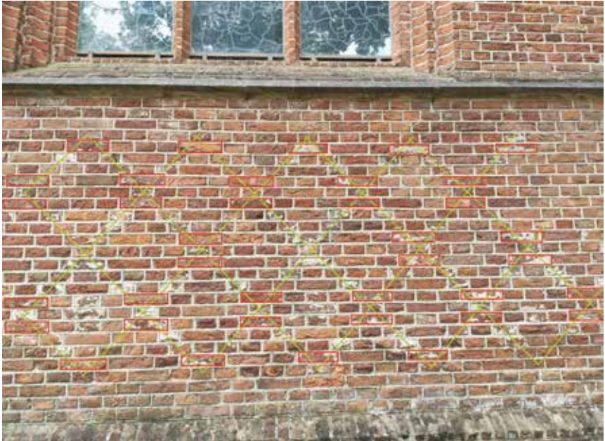
Afb. 2 Het patroon van de metseltekens middels toegevoegde lijnen verduidelijkt. (Fotobewerking Marc Robben)
