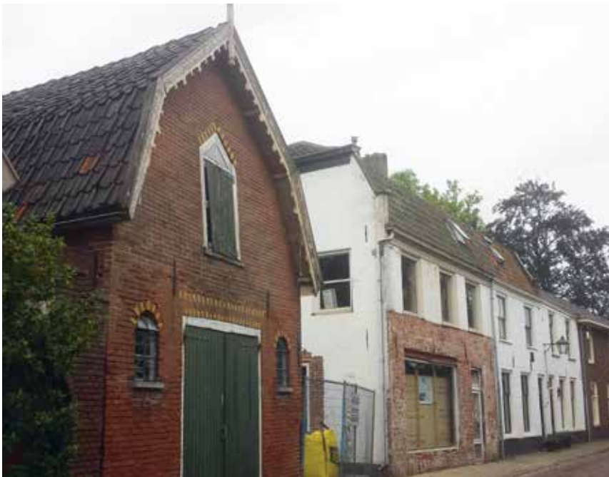
Afb. 9. Breedstraat 9 en 13 in staat van verbouwing, 2016.
