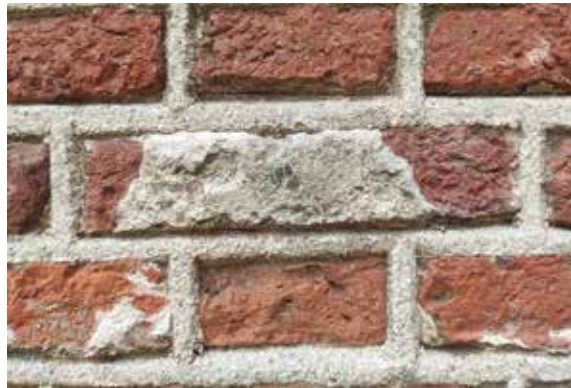
Afb. 4 Voorbeeld van nog gedeeltelijk met mortel bedekte stenen uit een van de metseltekens.
