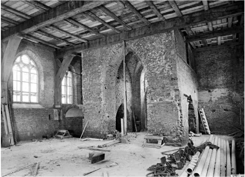
Afb. 11 De kerk tijdens de restauratie in 1965, met goed zichtbaar de torennis met de toegang tot de kerk, waarboven het orgel geplaatst zou gaan worden. (Foto RCE)
