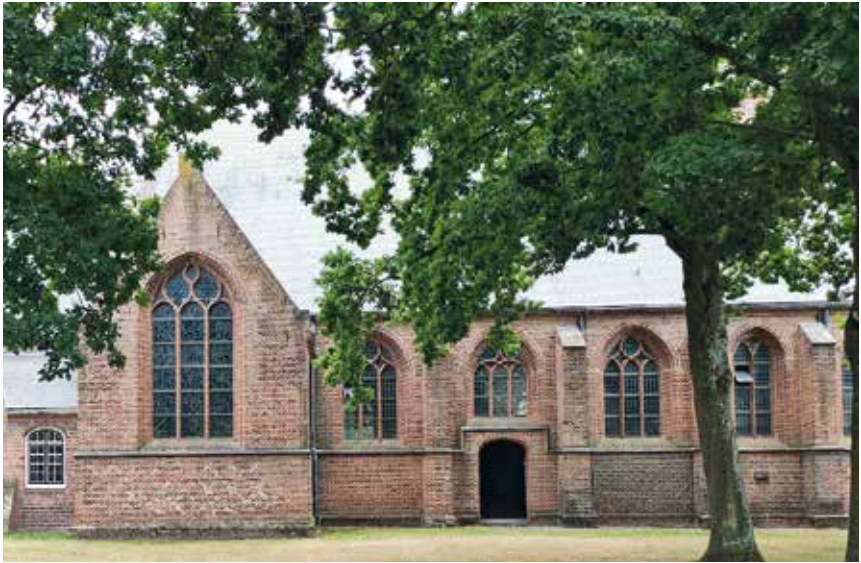
Afb. 1 Metseltekens in de vorm van ruitkruizen op de noordgevel van de kerk, aan de linkerkant, onder het glas in loodraam.
