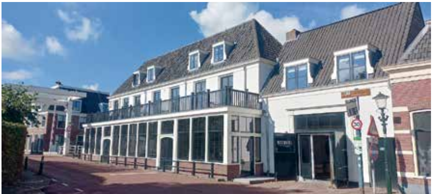
Afb. 6 Het hotel-restaurant september 2022.
