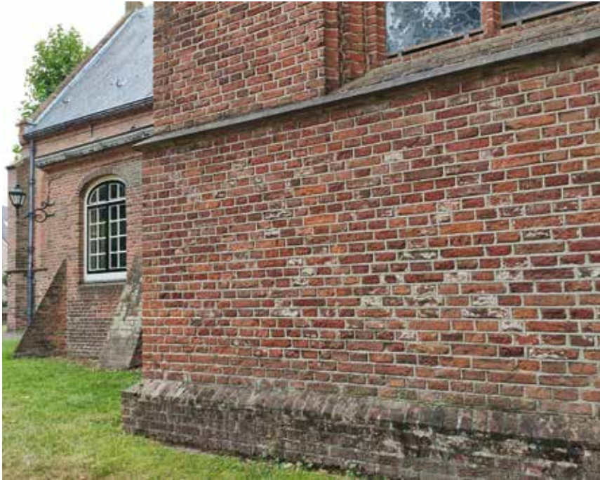
Afb. 3 Het ruitpatroon op de noordgevel.
