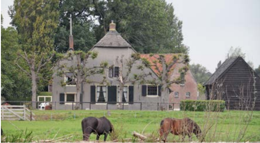
Afb. 4 Boerderij Op 't Slijk met aangebouwde herenkamer.
