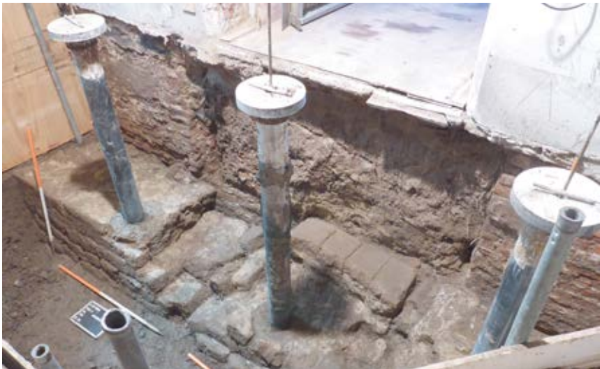
Afb. 5 De tijdens de opgraving aangetroffen tufstenen muur met in het midden de dorpel (BAAC).
