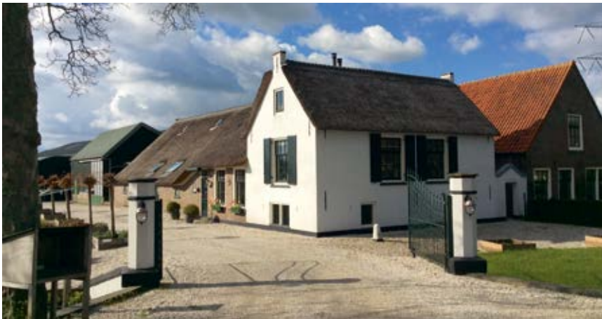
Afb. 9 De oorspronkelijke, wit gestucte met riet gedekte boerenwoning uit de eerste helft 18 e eeuw, nu rijksmonument, Gein Zuid 46, gebouwd door Pieter Schout Muilman, op het meest noordwestelijke deel van zijn landerijen aan het Gein (situatie in 2021; foto: Fred Duin)
