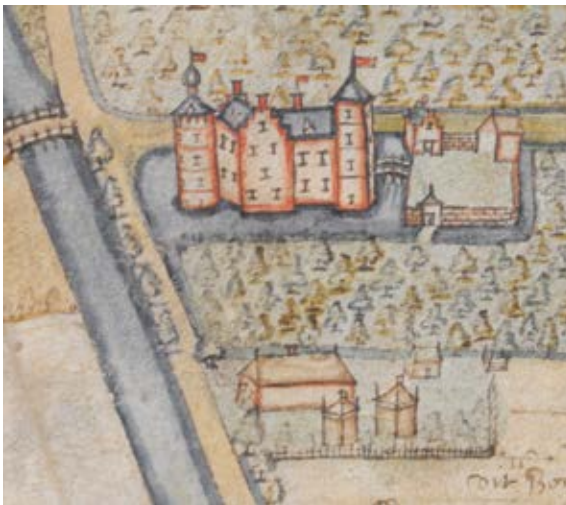
Afb. 6 Manuscriptkaart van Gunterstein, ingekleurde pentekening van Jan Rutgersz. van den Berch, 17 sept. 1604 (coll. Gunterstein, in bewaring bij het Regionaal Historisch Centrum Vecht en Venen, Breukelen). Detail: het kasteel met de voorburcht en de boerderij.
