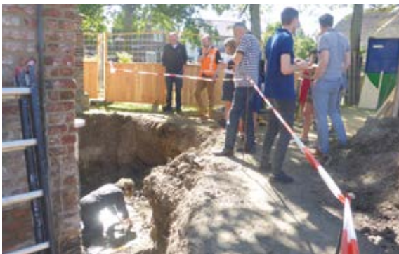
Afb. 3 Een impressie van de werkzaamheden: de werkput aan de zuidkant van de kerktoeren (BAAC).
