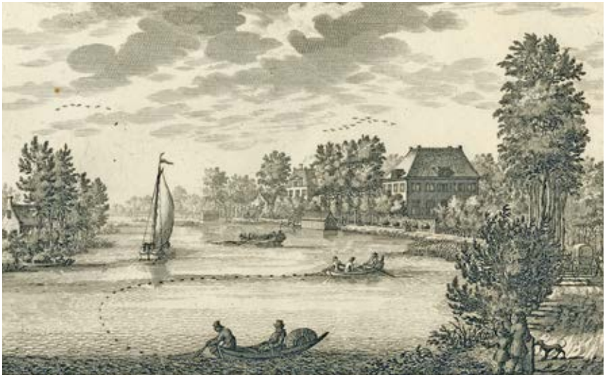
Afb. 5 Gezicht bij Nigtevecht in zuidwestelijke richting aan de Vecht. Het pand in het midden op de noordwestelijke oever van de Vecht is de buitenplaats Roosendaal van de weduwe van Albert Bentes, schepen te Amsterdam (nu Klompweg 30). Rechts hiervan staat het huis van Quirijn Brantjes en ongeveer achter het zeil van de tjalk ligt het toen nog naamloze buiten van Van Dam, ca. 450 m zuidwestelijk van Roosendaal (gravure nr. 89 door Daniel Stoopendaal in De Zegepraalende Vecht , 1719).
